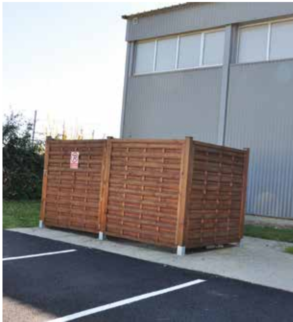
> Réfection du local poubelle
